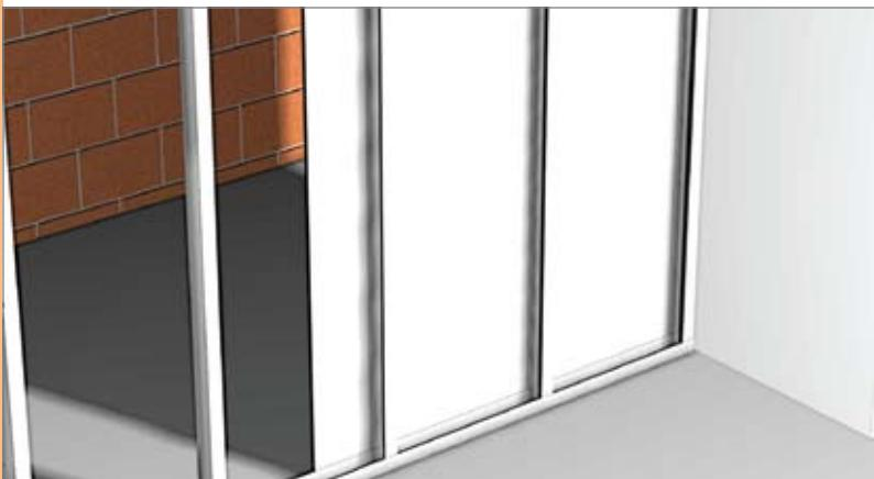
U prostor između elemenata konstrukcije postavljamo zvučnu, toplinsku i protupožarnu izolaciju od KNAUF INSULATION proizvoda. Voditi računa da cijelokupni prostor, osobito na vrhu zida mora ispunjen izolacijskim materijalom kako bi se izbjegla mјesta zvučnih i toplinskih mostova.
