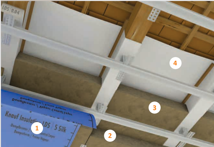
Slika 3: kosi krov - sanacija s unutarnje strane
