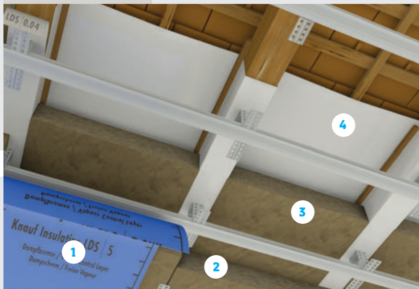
Slika 3: Kosi krov - sanacija s unutarnje strane
